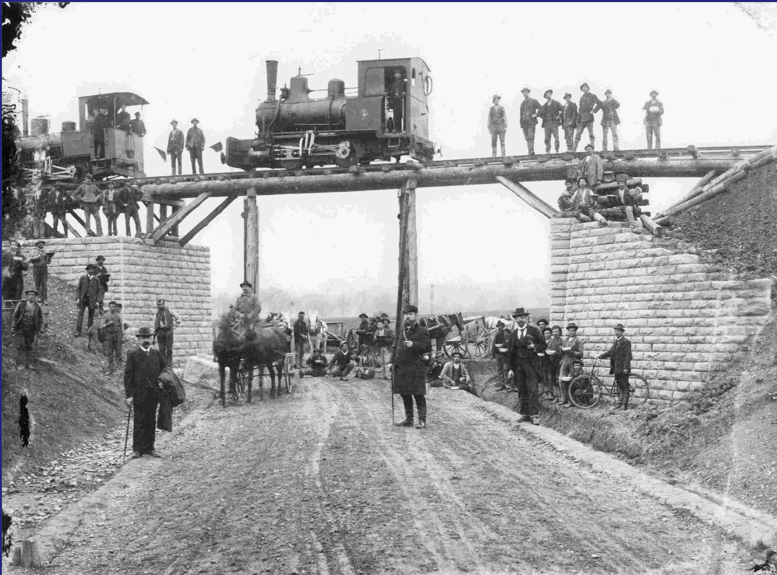
Brückenbau in Lipbach: Die Arbeiter machen Mittagspause und haben ihre Teller in der Hand, Vertreter der Bauleitung sind an der Baustelle, kleine Arbeitslokomotiven befahren die provisorische Brücke.
