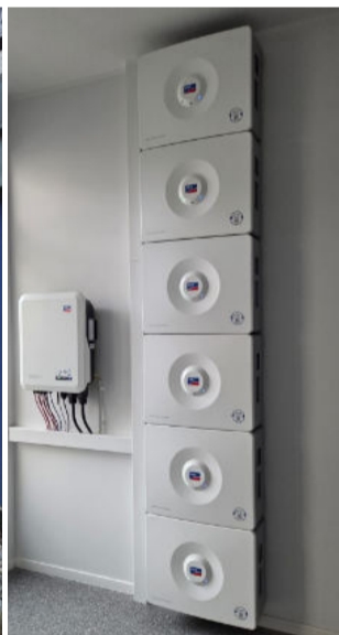
Abbildung links außen: Kompakte Wärmepumpe mit Balkonkraftwerk Bild daneben: Batteriespeicheranlage mit Wechselrichter Fotos: Haustechnik Schreyer GmbH
