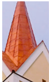
Großes Bild links: Christian Nitz auf dem Arbeitsplatz in luftiger Höhe Kleines Bild: Der fertig sanierte Kirchturm in Kemnath am Buchberg
