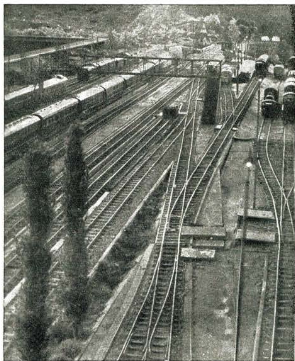
Bild 7 „So muß eine Weichenstraße aussehen“, erklärte Fritz Rust, nachdem er diese durch Auswechslung einiger Weichen begradigt hatte
