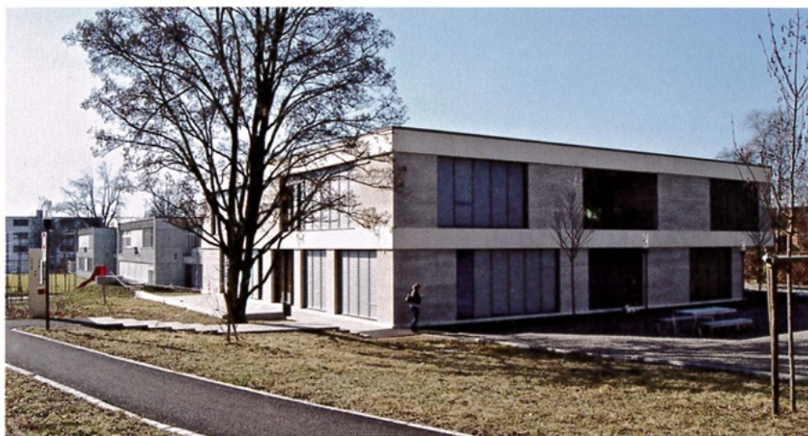
Das sanierte und erweiterte Schulhaus Meiliwiese (Bild Roland Glättli)
