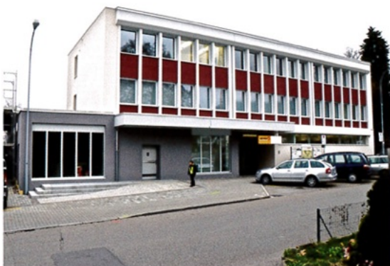
Die Post erhielt eine umfassende Sanierung. (Bilder Roland Glättli)
