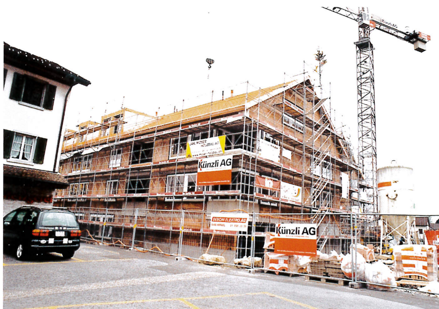
Aufrichte an der Zürichstrasse 1 im Oktober 2006
