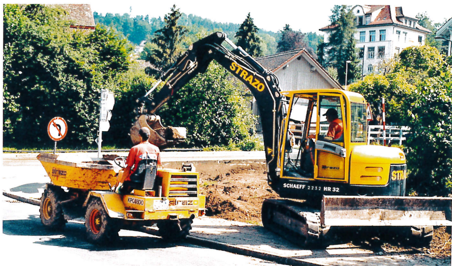
Umgestaltung der Kreuzung Bachtel-/Waldenstrasse
